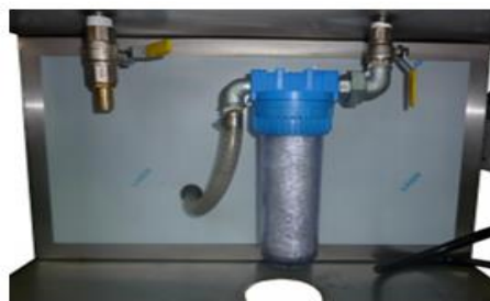
Standard filter for rensing av partikler 100 micron, bestillingsvare 1-300 micron
