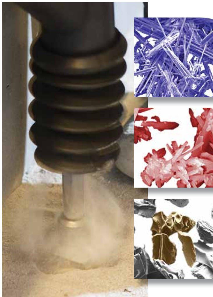
Dammfri bilning med hjälp av Dustcontrols sugkåpor.
