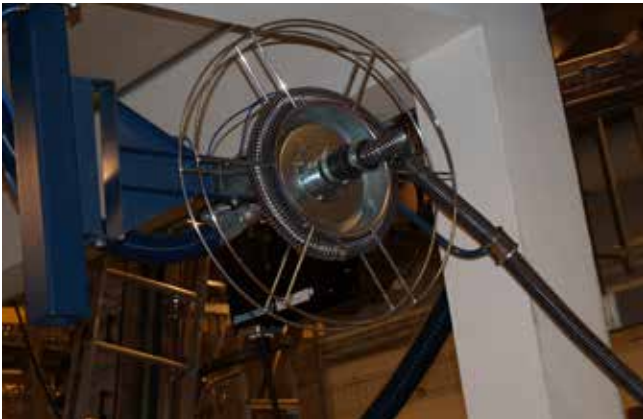
Dustcontrol slangupprullare installerad vid varje arbetsplats.
