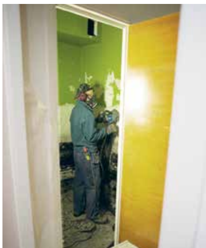
Slipmaskin försedd med en sugkåpa och luftrenaren DC AirCube som backup.
